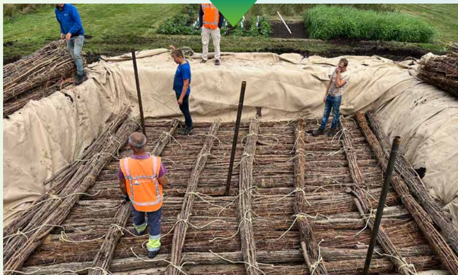
▼ Aanleg proef met wilgen als funderingsmateriaal in Zegveld (eerste laag wilgen).
